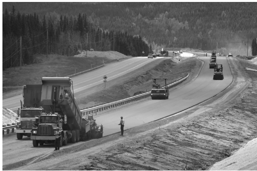
Pose de la couche de roulement sur la route 175 dans la réserve faunique des Laurentides, entre les kilomètres 167 et 168
