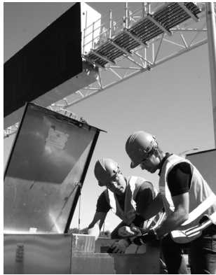
MM. Dominique Goulet et Pierre-Paul Landry, techniciens en électrotechnique au Centre intégré de gestion de la circulation de la Direction de la Capitale-Nationale, inspectent un coffret de relèvement pour panneaux à messages variables aériens sur le chantier de l'échangeur Charest/Robert-Bourassa, à Québec.
