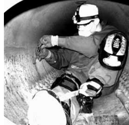
Travaux d'entretien de ballons de chaudière.
