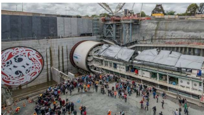
(b) Mise en position du tunnelier sur le tympan
