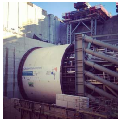
(c) Début de poussage sur un portique métallique de butée
