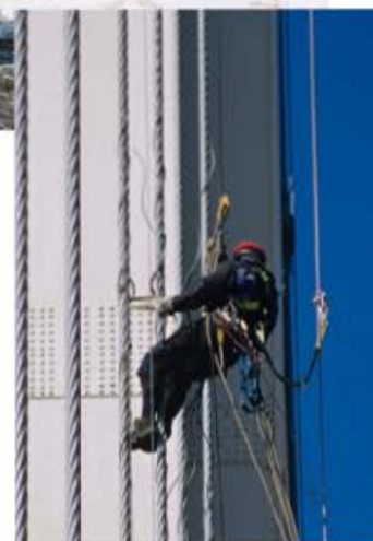
Inspection en appui sur cordes
