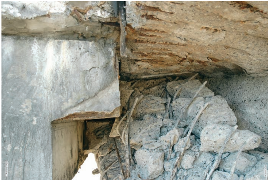
Figure 6.6 Photo de la région de la chaise vers le centre de la culée où la rupture de la dalle s'est arrêtée 8
