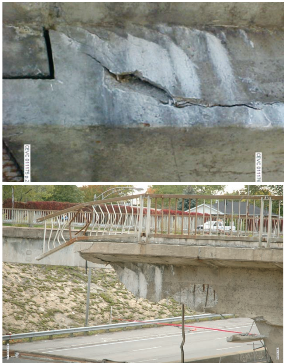
Figure 6.1 Face verticale du côté sud de la culée est près de la chaise: a) ci-dessus, photographié par Jules Bonin le 30 septembre 2006, moins d'une heure avant l'effondrement b) après l'effondrement
