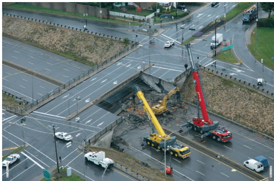
Figure 3.1 Partie effondrée du viaduc de la Concorde 3
