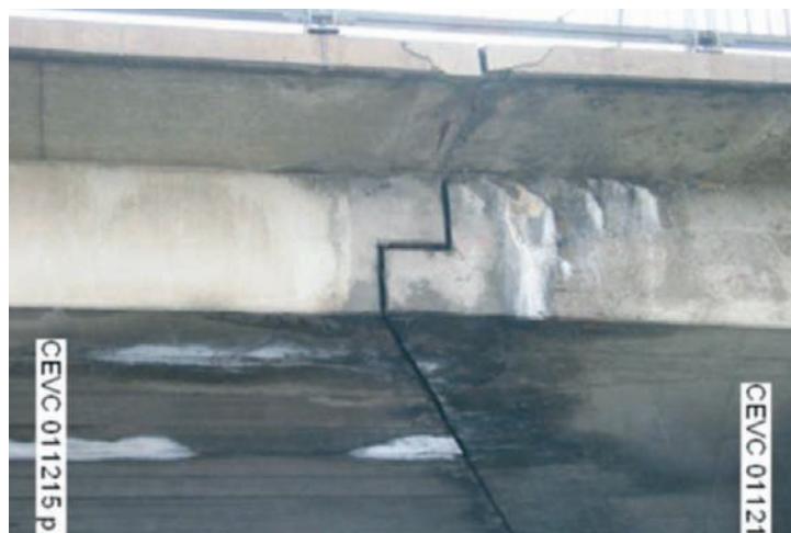
Figure 5.6 Vues du porte-à-faux est, du côté sud du viaduc de la Concorde montrant l'évolution de la fissuration dans la région de la chaise 78
