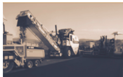
Utilisation d'un véhicule de transfert des matériaux permettant d'améliorer les propriétés de l'enrobé et de l'uni de surface.
