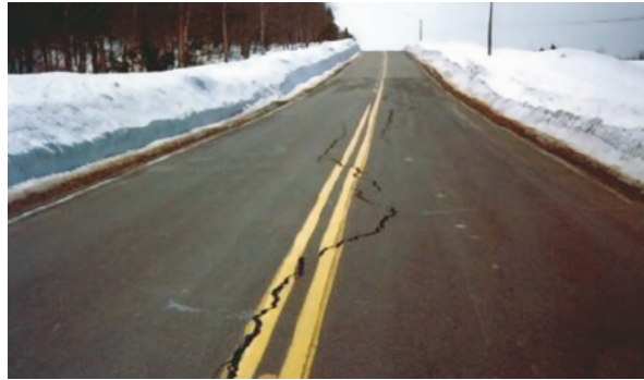
Figure 12 Chaussée présentant une lézarde causée par le gel
