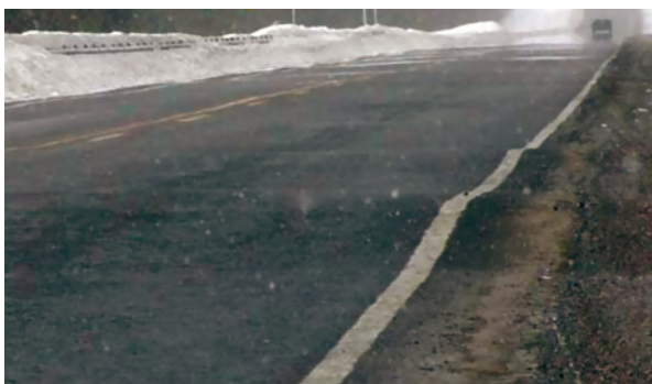
Figure 11 Chaussée présentant un soulèvement de 20 cm
