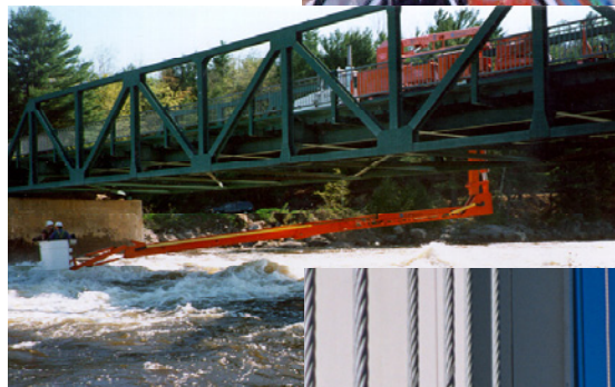
Inspection à l'aide de la nacelle
