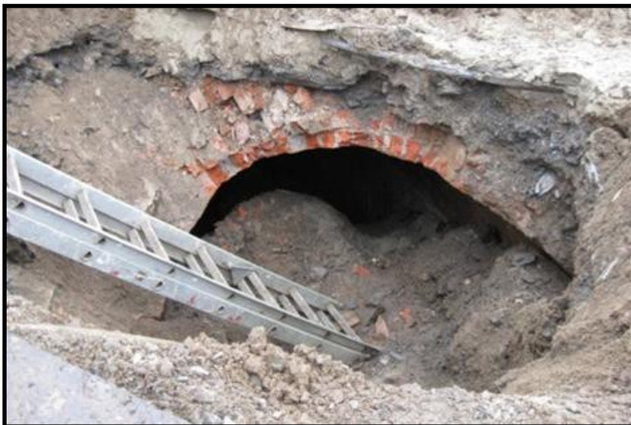
PHOTOS 19 et 20. Coupe d'un tunnel militaire à Lévis. On remarque trois épaisseurs de briques, tout comme pour les tunnels situés devant le Parlement.
