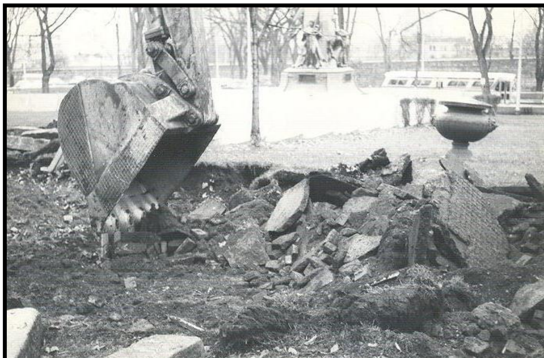
PHOTO 14. Les pavés d'origine du Parlement furent enlevés à la pelle mécanique et servirent de matériau de remplissage du fleuve du côté de Beauport.
