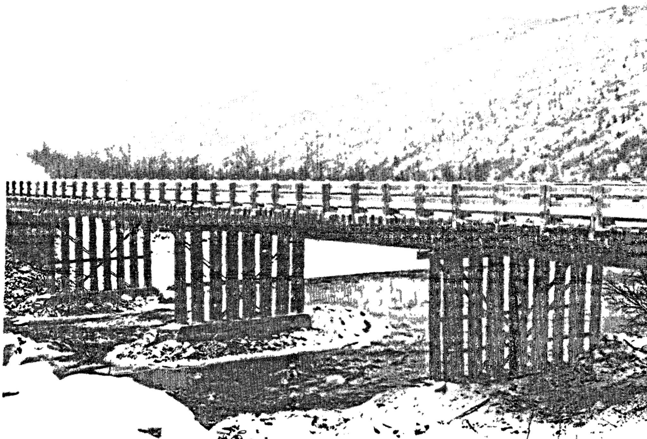
Pont sur la rivière York, route Gaspé-Murdochville Pontage de bois sur poutres et chevalets en acier
