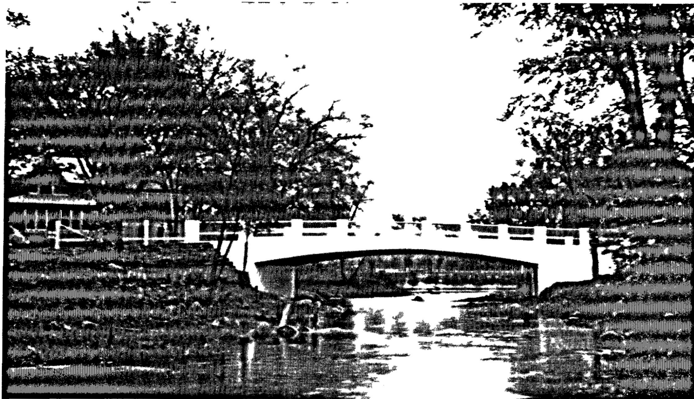
3. Pont au village d'Athelstan sur la riv. Hinchinbrook, Cté Huntingdon. — Pont en béton armé à cadre rigide, comprenant une travée de 70'-0". Dalle en béton armé sur culées en béton. Largeur de voie charretière 22'-0". Un trottoir de 4'-0". Construit en 1940.
