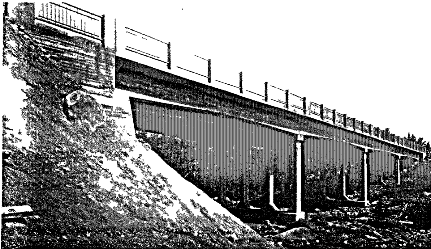
Pont sur la rivière aux Mulets à Ste-Adèle, comté de Terrebonne. Route No 11 (Montréal-Mont-Laurier).—Pont en béton armé ayant une longueur totale de 260'-0'', face à face des petits murs de butée, formé de 4 travées de 65'-0'', reposant sur deux culées en béton et trois piliers en béton armé. Dalle en béton armé. Largeur de voie charretière 36'-0''. Deux trottoirs de 3'-6''. Construit en 1941. Bridge over "Rivière aux Mulets" at Ste. Adele, County of Terrebonne, on Route No. 11 (Montreal Mont-Laurier).—Reinforced concrete bridge. Four 65'-0" spans forming a total length of 260 feet between ballast walls. Two concrete abutments and three reinforced concrete bents. Reinforced concrete deck. Clear roadway 36'-0" wide and two 3'-6" sidewalks. Built in 1941.
