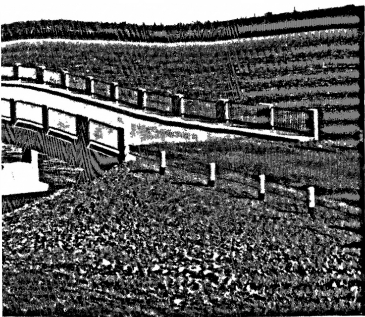
ibi. Route: Rouyn-Val d'Or. —Pont en béton armé ayant une es de 75'-0'', reposant sur substruction composée de cinq piliers en eur de la voie charretière 24'-0''. Un trottoir de 4'-0''. Construit
