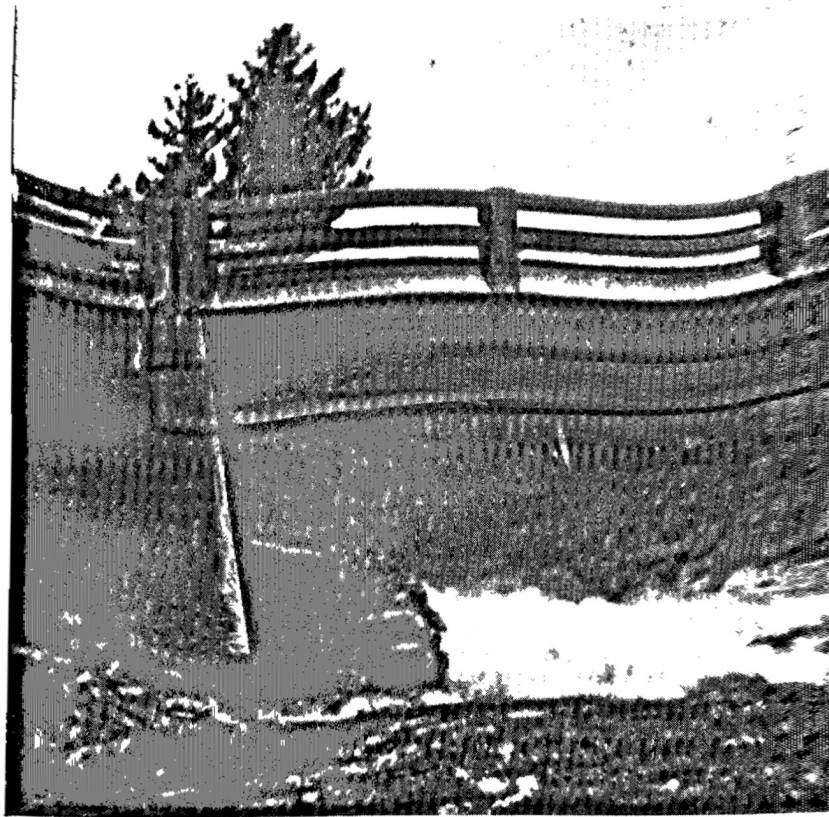
Pont de la "Chute à Magnan" sur la rivière du Loup entre St-Paulin, et St-Alexis-Shawinigan Falls. —Pont en béton armé, formé d'une travée de béton. Dalle et poutres en béton armé. Largeur de la
