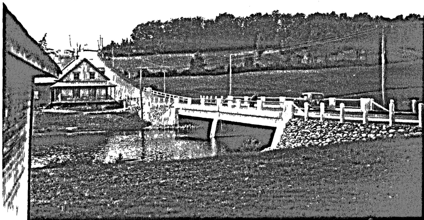
FIG. 10.- PONT SUR LA RIVIERE HAMEL A ST-EPHREM, COMTE BEAUCE. (ROUTE BRAUCEVILLE-SHERBROOKE).—Dalle en béton armé et poutres en acier entourées de béton sur substruction en béton. Deux travées formant une longueur totale de 93 pieds et 6 pouces. Voie charretière de 24 pieds de largeur. Construit en 1931.
