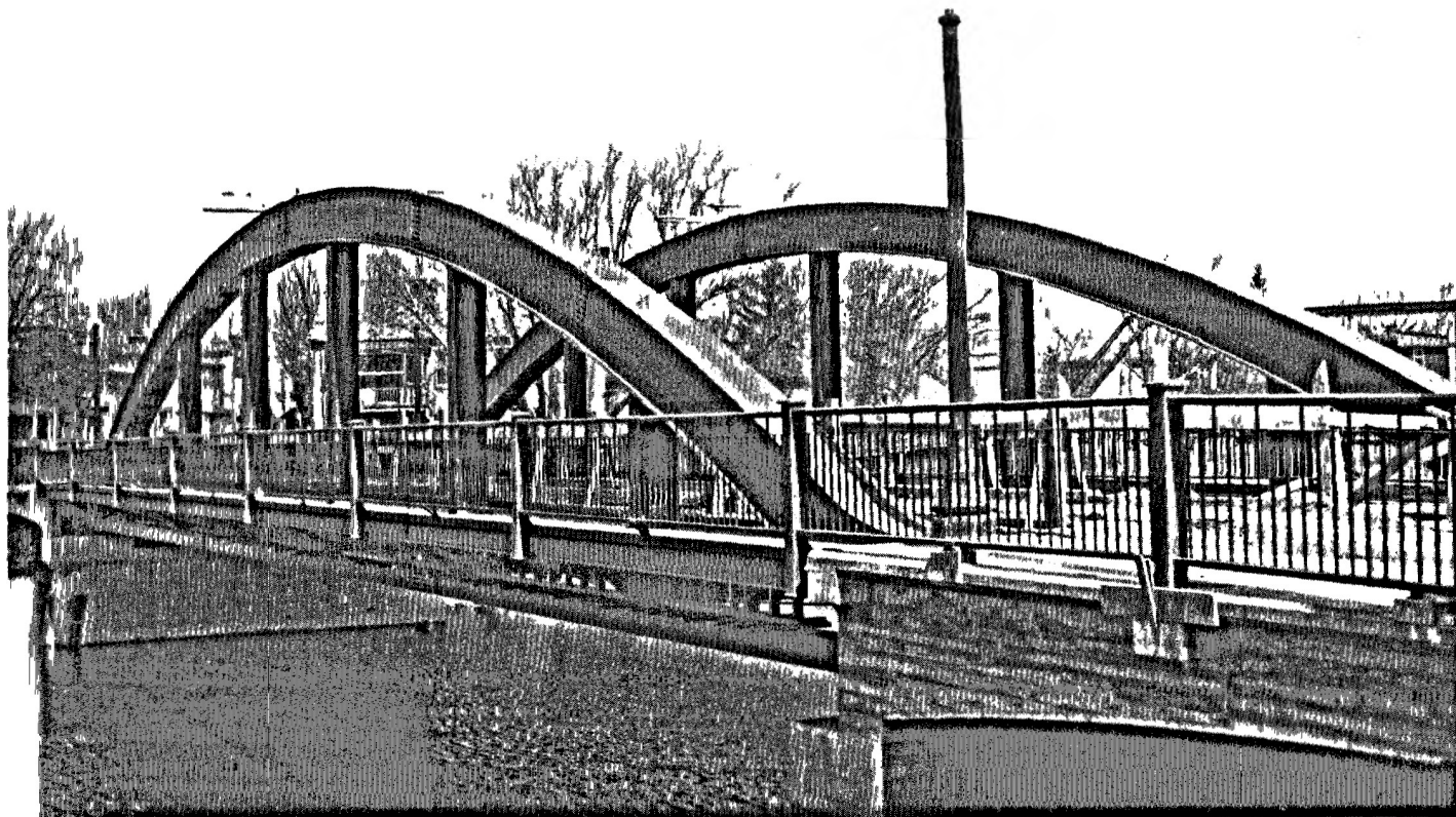
FIG. 6.—PONT SUR LA RIVIERE CHATEAUGUAY A ORMSTOWN, COMTÉ CHATEAUGUAY. (ROUTE MONTREAL-MALONE.—Ce pont, dont la longueur totale est de 220 pieds, est formé d'une arche métallique de 140 pieds et de deux travées adjacentes en béton armé de 40 pieds chacune reposant sur piliers et culées en béton. Largeur de la voie charretière: 27 pieds. Un trottoir de 4 pieds et 6 pouces. Construit en 1934.
