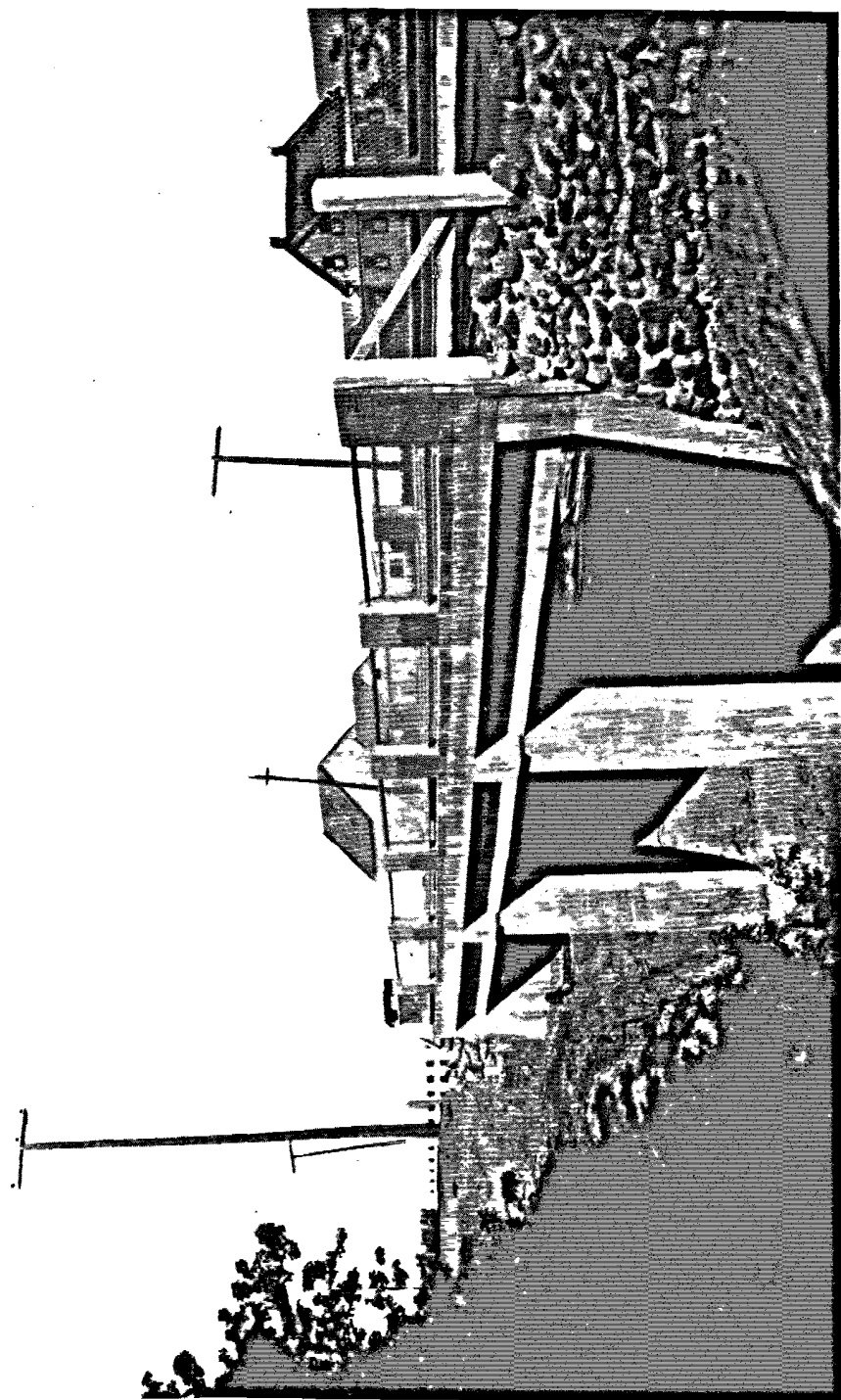
FIG. 14.—PONT "DE LA FROMAGERIE" SUR LE RUISSEAU BOIS BLANC A ST-JUSTIN, COMTE MASKINONGE.—Tablier en béton armé sur substruction en béton. Trois travées formant une longueur totale de 87 pieds. Largeur de la voie charretière 18 pieds. Construit en 1933.
