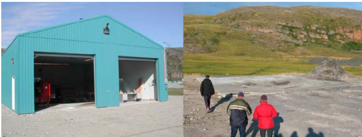
FIGURE 5.49 : GARAGE DES POMPIERS DE SALLUIT. CONSTRUIT EN 2003 SUR UNE DALLE DE BÉTON, IL A DÛ ÊTRE DÉMOLI APRÈS QUE LE PLANCHER SE SOIT AFFAÎSSÉ D'ENVIRON 0,50 M À LA SUITE DU DÉGEL DU PERGÉLISOL SOUS LA FONDATION.
