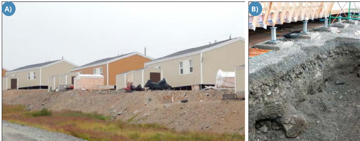
FIGURE 5.63 : A) EXEMPLE D'AMÉNAGEMENT D'UN TERRAIN LÉGÈREMENT EN PENTE AVEC RADIER EN ESCALIER. B) STRUCTURE D'UN REMBLAI AVEC DIFFÉRENTS CALIBRES DE MATÉRIAUX GRANULAIRES.
