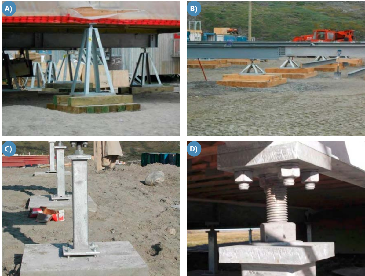
FIGURE 5.67 : A ET B) TRÉPIEDS POSÉS SUR UNE SEMELLE DE BOIS MUNIS DE VÉRINS AJUSTABLES REPOSANT SUR UN REMBLAI GRANULAIRE (SOURCE : QUADRIVIUM). C) PILIER POSÉ SUR UNE SEMELLE EN BÉTON LÉGÈREMENT ENCASTRÉE DANS UN REMBLAI GRANULAIRE. D) TÊTE DE PILIER MUNIE D'UN VÉRIN AJUSTABLE.
