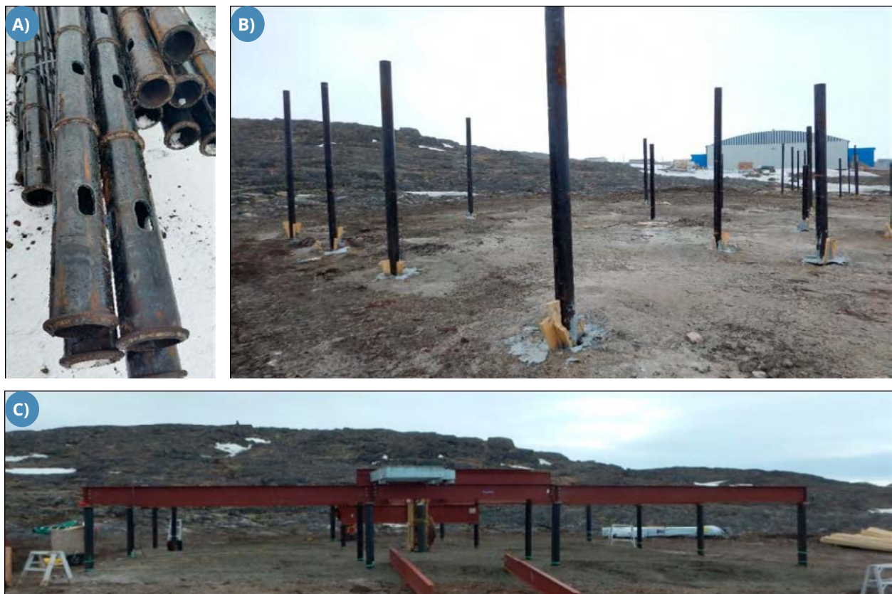
FIGURE 5.77 : A) PIEUX SUR LESQUELS DES COLLETS D'ACIER ONT ÉTÉ SOUDÉS ET DES TROUS PERCÉS AFIN D'ACCROÎTRE LA CAPACITÉ PORTANTE (MENTION DE SOURCE : G. ROBICHAUD, 2015). PIEUX PORTANT EN POINTE SERVANT DE FONDATION AU PROTOTYPE D'HABITATION DE LA SHQ À QUAQTAQ LORS B) DE LA MISE EN PLACE DU COULIS ET C) UNE FOIS COUPÉS AU NIVEAU AVEC LA SOLIVE DE RIVE FIXÉE (SOURCE : E. L'HÉRAULT, CEN, 2015).
