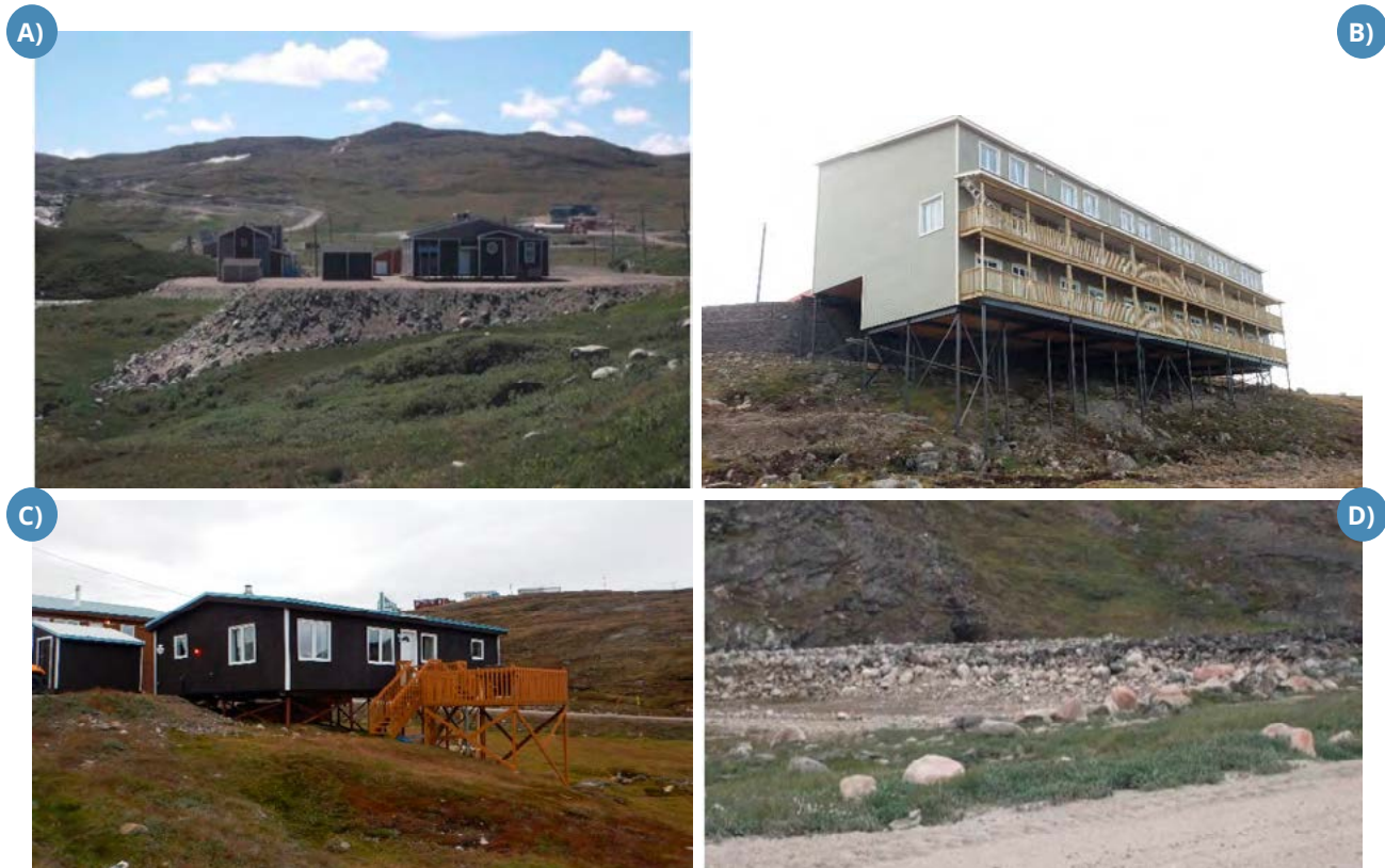
FIGURE 5.92 : A) REMBLAI GRANULAIRE TRÈS ÉPAIS SUR UN TERRAIN EN PENTE À SALLUIT AU NUNAVIK. B) ET C) SYSTÈME DE FONDATION ADAPTÉ À LA TOPOGRAPHIE DU TERRAIN PRENANT DIRECTEMENT APPUI SUR LE ROC À IQALUIT AU NUNAVUT. D) REJETS DE CONCASSEUR POUVANT ÊTRE UTILISÉS DANS LA CONSTRUCTION DE RADIER GRANULAIRE (SOURCE : N. JOURNEAUX).
