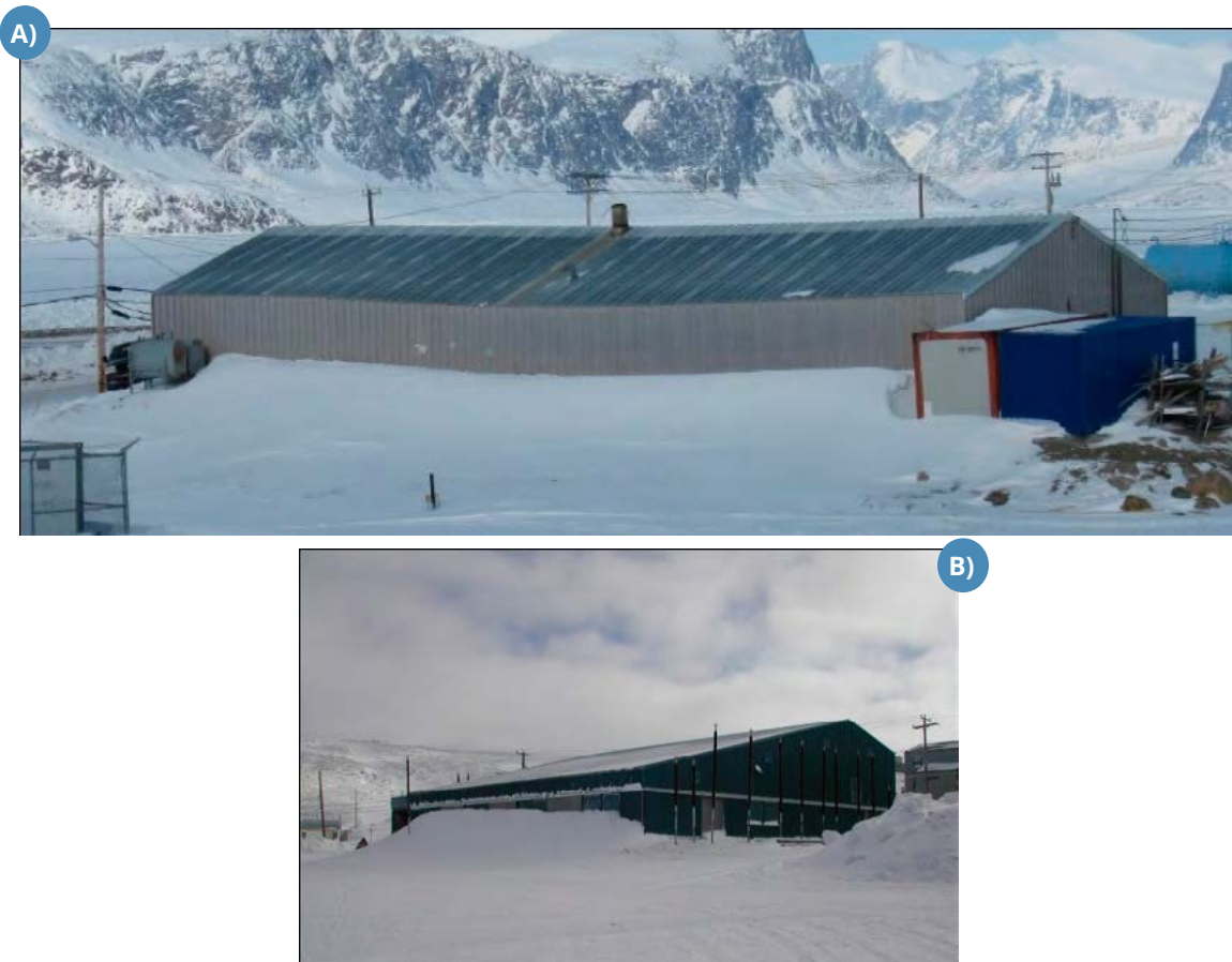
FIGURE 5.87 : A) ET B) BÂTIMENTS DONT LA FONDATION REPOSE DIRECTEMENT SUR LE SOL, FAVORISANT L'ACCUMULATION DE NEIGE (SOURCE : E. L'HÉRAULT, CEN, 2010).
