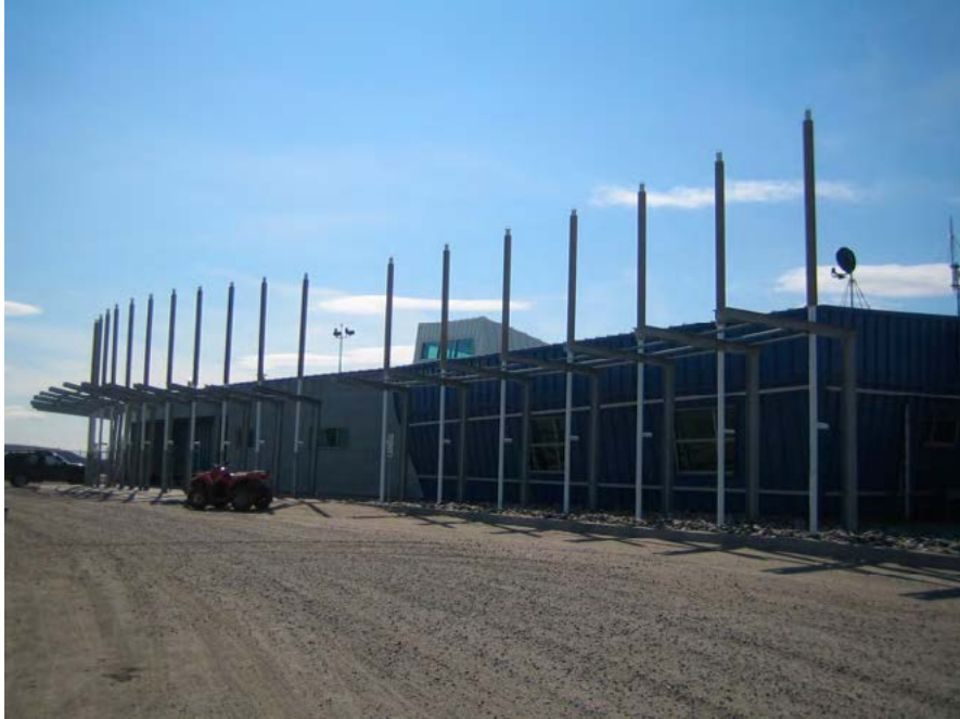
FIGURE 5.82 : SYSTÈME DE FONDATION AVEC THERMOSIPHONS À L'AÉROGARE DE L'AÉROPORT DE KUUJJUAQ AU NUNAVIK (PHOTO PRISE PAR CLAUDE LEPAGE).
