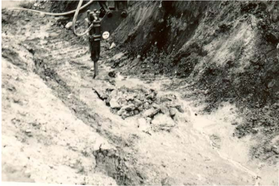
FIGURE 5.18 : MARTEAU PIQUEUR, EXCAVATION DU PERGÉLISOL DANS UN TILL À KANGIQSUALUJUAQ.
