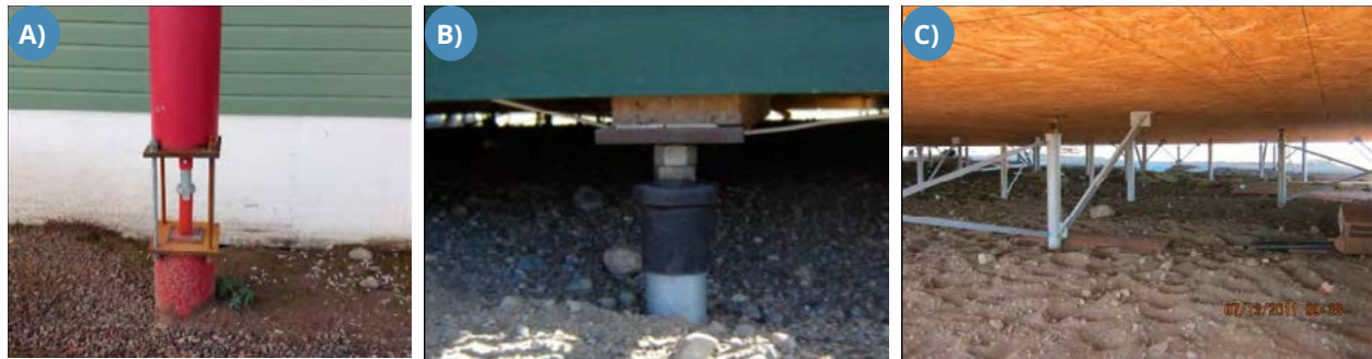
FIGURE 5.76 : A) ET B) TÊTES DE PIEUX AJUSTABLES (MENTION DE SOURCE : E. L'HÉRAULT, CEN, 2015). C) CONTREVENTEMENTS (SOURCE : N. JOURNEAUX).
