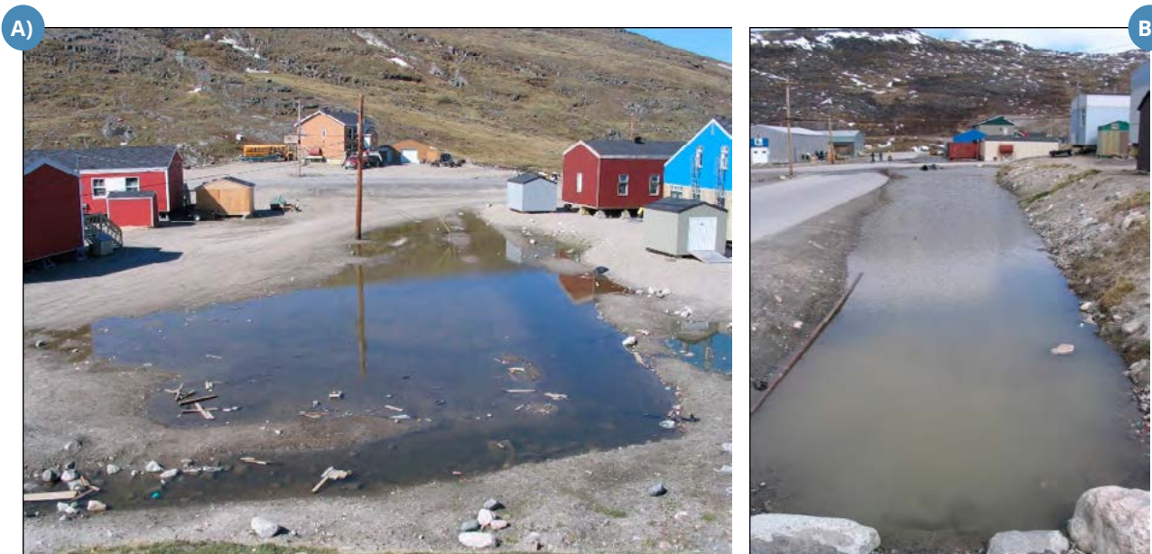
FIGURE 5.91 : ACCUMULATION IMPORTANTE D'EAU A) EN PÉRIPHÉRIE D'UN REMBLAI ET B) DANS UN FOSSÉ DE DRAINAGE (SOURCE : E. L'HÉRAULT, CEN, 2008).
