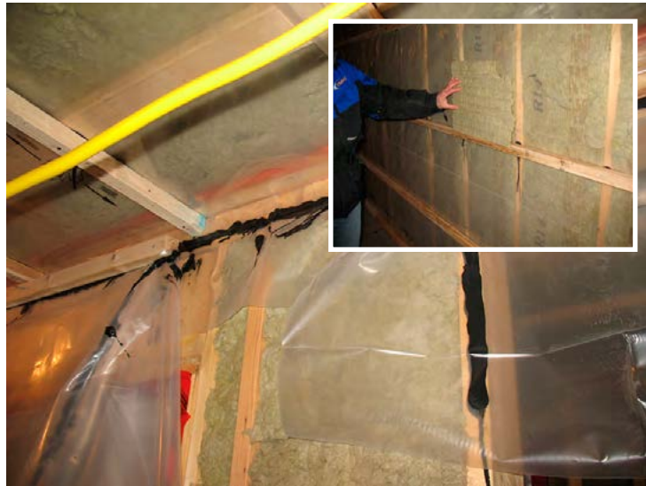
FIGURES 3.6 : SYSTÈME PARE-VAPEUR À L'INTÉRIEUR D'UN MUR SOURCE : SHQ
