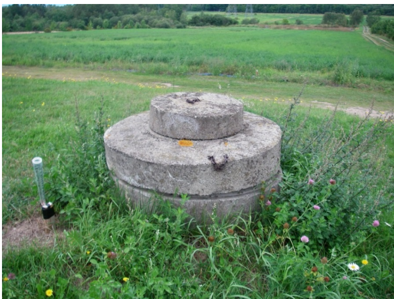
Figure 15 Puits utilisé pour l'échantillonnage des pesticides dans les eaux souterraines en milieu agricole
