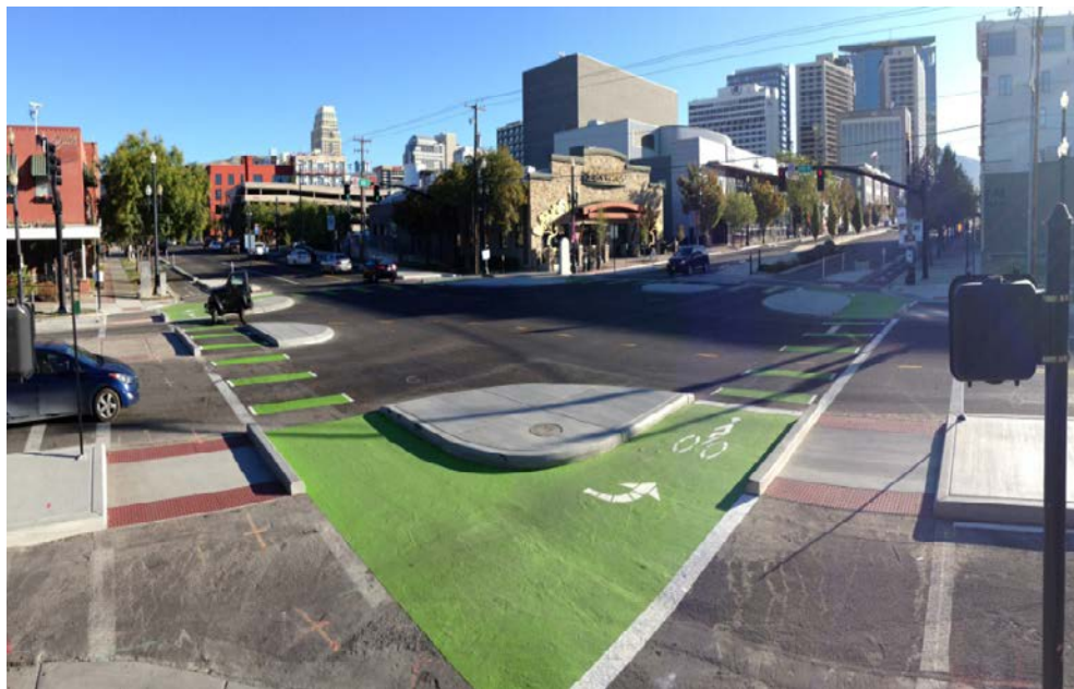
Figure 6 Une intersection protégée à Salt Lake City
