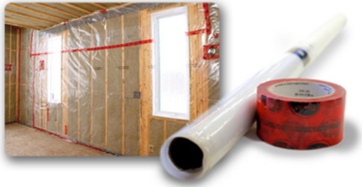
FIGURE 3.6 : SYSTÈME PARE-VAPEUR À L'INTÉRIEUR D'UN MUR SOURCE : GOOGLE IMAGES
