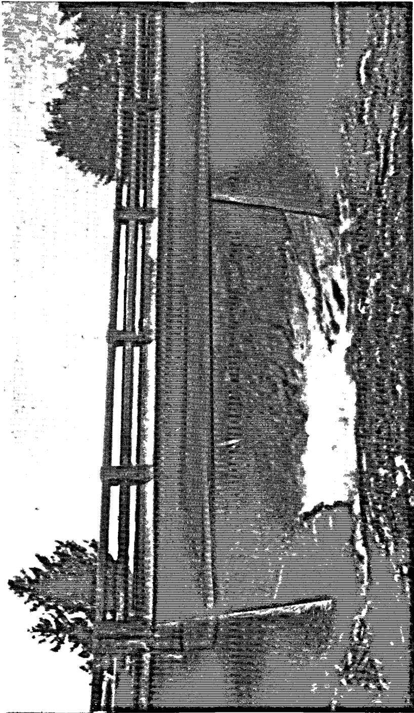
Pont de la "Chute à Magnan" sur la rivière du Loup entre St-Paulin, comté Maskinongé, et Charette, comté St-Maurice. Route: St-Alexis-Shawinigan Falls. —Pont en béton armé, formé d'une travée de 60'-0" face à face des murs de butée, reposant sur deux culées en béton. Dalle et poutres en béton armé. Largeur de la voie charretière 24'-0". Construit en 1943.
