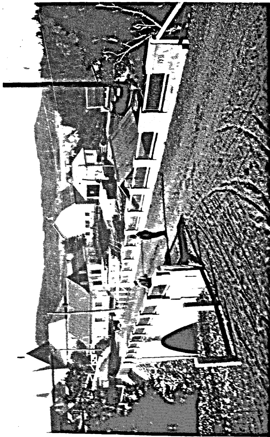
PONT "TURCOTTE" SUR LA RIVIÈRE DU BIC, AU BIC, COMTÉ DE RIMOUSKI.—Ce pont comprend une arche en béton armé d'une longueur de 80 pieds, avec une voie charretière de 20 pieds de largeur. Construit en 1931.
