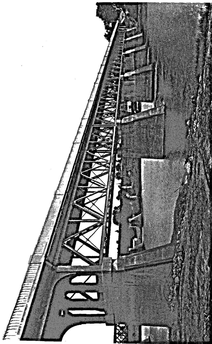
PONT SUR LA RIVIÈRE ST-FRANÇOIS ENTRE ST-FRANÇOIS-DU-LAC ET ST-THOMAS-DE-PIERREVILLE, COMTÉ D'YAMASKA. — Vue montrant la partie du pont immédiatement au-dessus de la rivière, soit la partie à superstructure métallique avec tablier supérieur. Les trottoirs sont en porte-à-faux, avec balustrades en béton armé. On remarque à l'arrière plan, le pont du chemin de fer.
