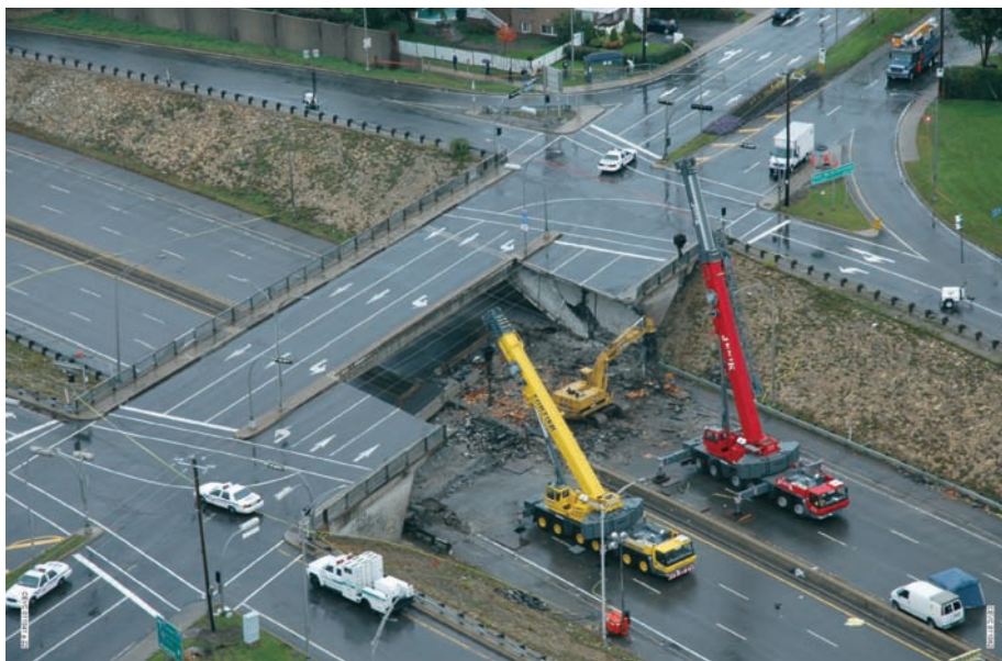
Figure 3.1 Partie effondrée du viaduc de la Concorde 3
