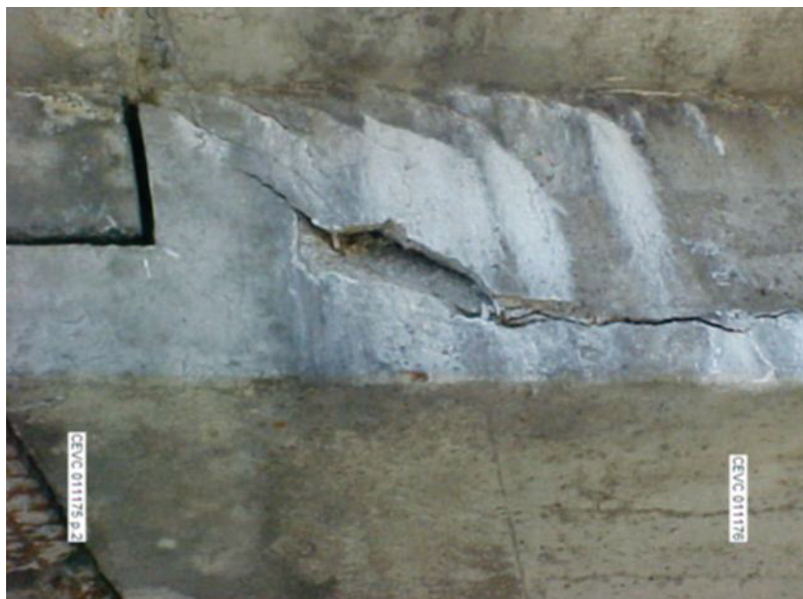
Figure 3.3 Trou et fissure dans la culée est, photographiés par M. Bonin entre 11 h 45 et 12 h, le 30 septembre 2006
